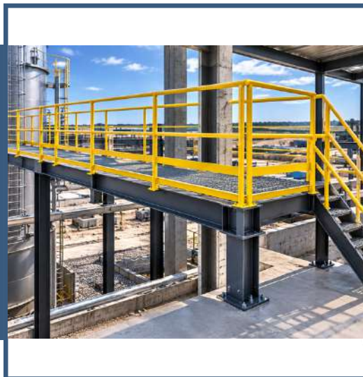
PASSARELA ELEVADA COM GUARDA CORPO
